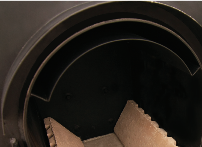
By-pass sistemi sayesinde kazan kapağının açıldığında kolay duman tahliyesi
